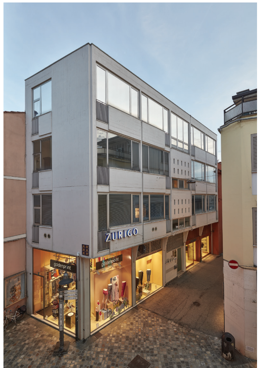
FABBRICATO PER NEGOZI E UFFICI VIA PASOLINI, RAVENNA 1960
